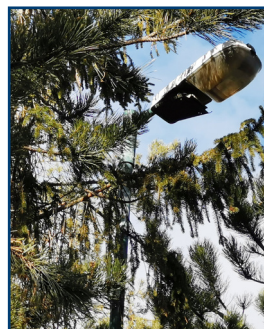
Beleuchtung am Fußweg: Zugewachsen und zerstört. Das sorgt in der Nacht für Fußgänger nicht für das beste Sicherheitsgefühl.
